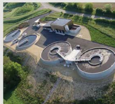
STATION D'ÉPURATION DE SAINT GELAIS (79)
